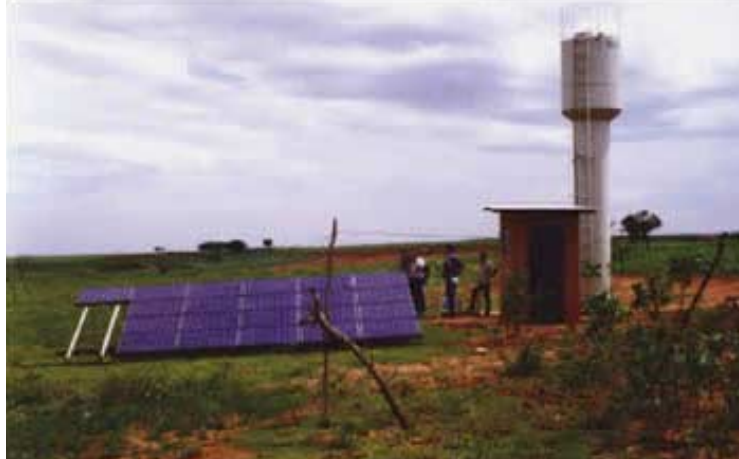
FIGURA 3.10 Sistema de bombeamento fotovoltaico – Santa Cruz I (Mirante do Paranapanema – SP)
