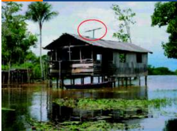
FIGURA 3.12 Sistema fotovoltaico para atendimento domiciliar – Projeto Ribeirinhas
