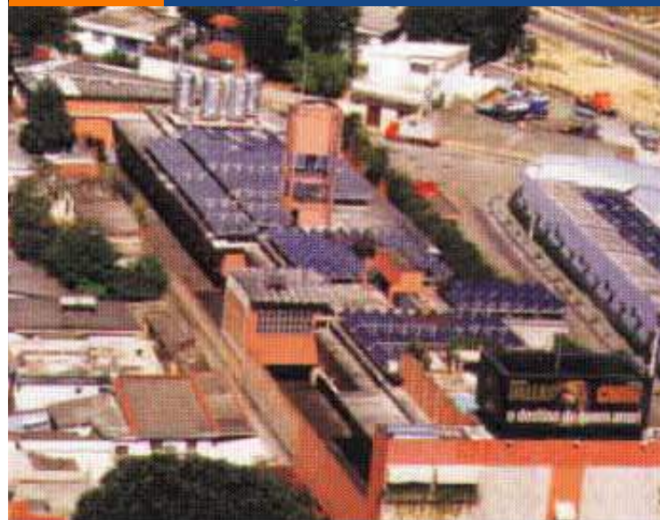
FIGURA 3.8 Sistema comercial de aquecimento solar de água (Belo Horizonte – MG)
