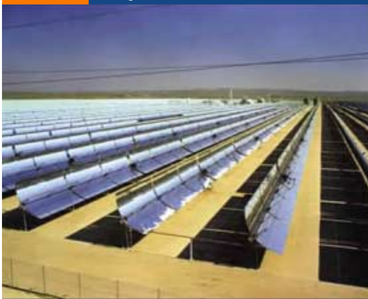
FIGURA 3.6 Sistema térmico de geração solar de energia elétrica (Califórnia – EUA)
